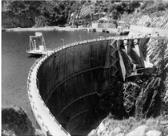
De Delcommune dam maakt nuttig gebruik van de Zilo kloven op de Lualaba rivier. Het is een boogdam van ongewapend beton, 72,5 m hoog en 162 m lang aan de top. Hij houdt een meer van 200 km 2 in stand met een nuttige reserve van 2.300 miljoen m 3 en voorziet een elektriciteitscentrale van 108.000 kW die in 1953 in gebruik werd genomen (UMHK).
