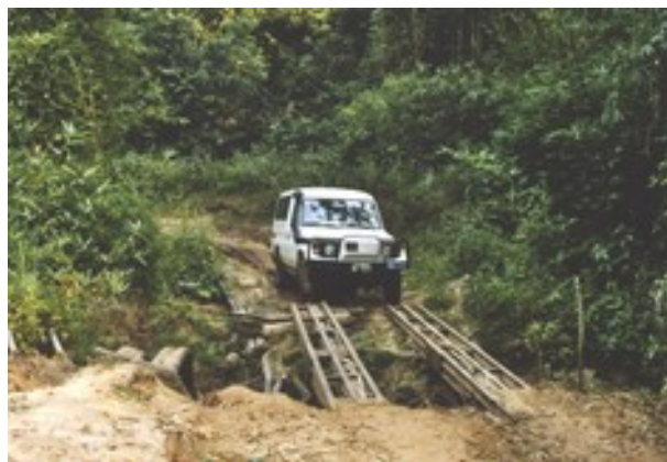
De kortste afstand tussen twee oevers is...een brug
