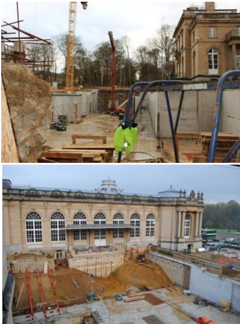
De actuele stand van de bouwwerf
