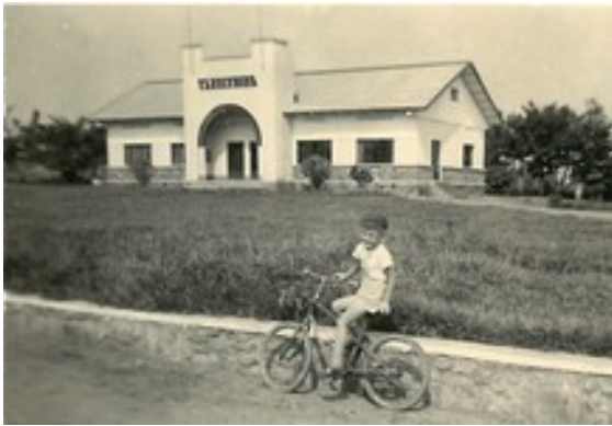
Het gebouw "Le Territoire": zetel en symbool van de gewestelijke overheid. Kasongo was een van de 117 gewestzetels in de kolonie.
